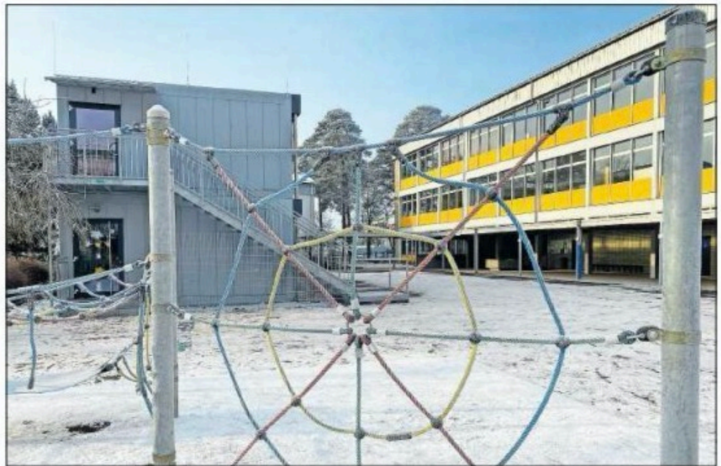
Weil die Klassensäle nicht ausreichen, steht auf dem Schulhof der Grundschule Enkenbach-Alsenborn ein doppelstöckiger Container (links im Bild). Die Schule soll – ebenso wie die Grundschule in Mehlingen – baulich erweitert werden, denn die Schülerzahlen werden in den nächsten Jahren steigen.
